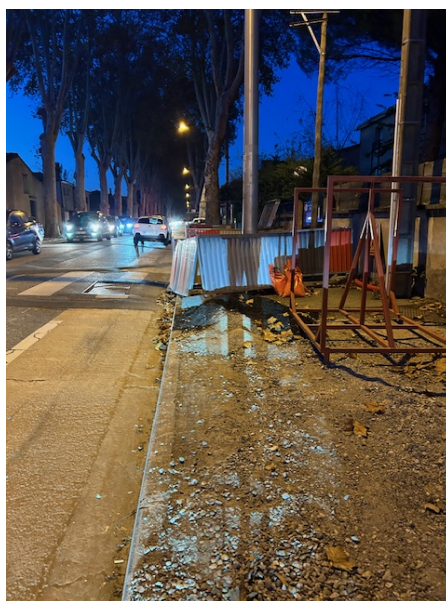
Les travaux ne sont pas encore terminés sur les trottoirs
